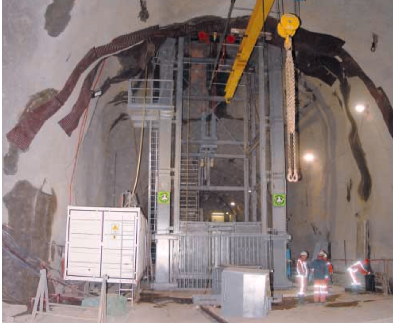
Führungsgerüst in der Kaverne
