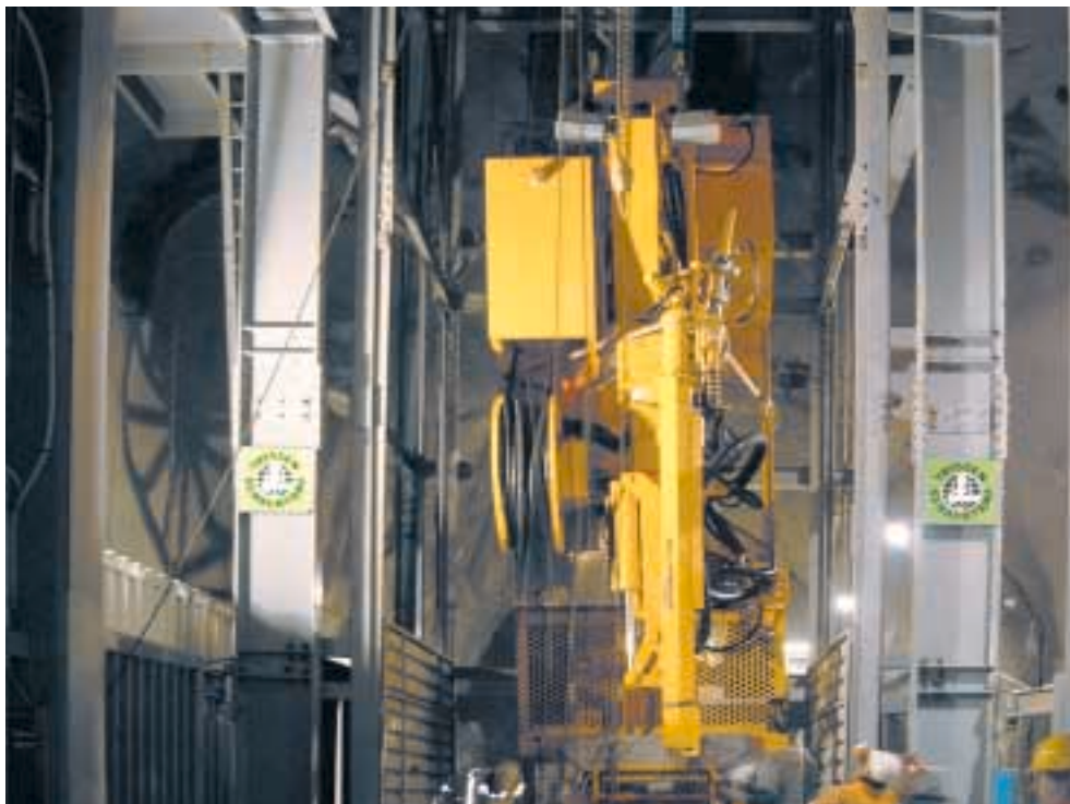
Schachtkopf mit Schwerlastkorb Schacht Sedrun II
