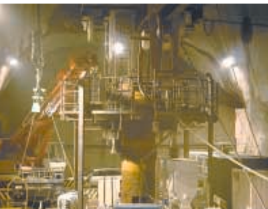
Schachtarbeitsbühne Sedrun Schacht II
