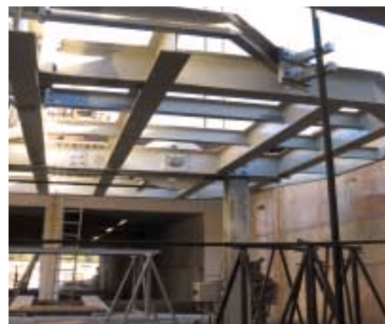
Bild unten: Montage des Kopf-schutzes der 1-etagigen Arbeitsbühne am Schachtkragen
