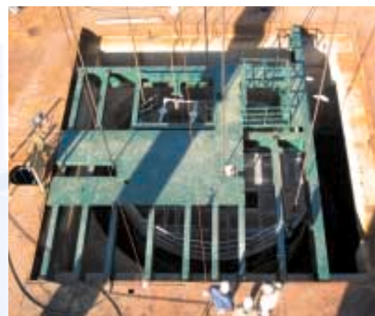
Montage der neuen Schachtabdeckung vom Kopf-schutzdach der 1-etagigen Arbeitsbühne
