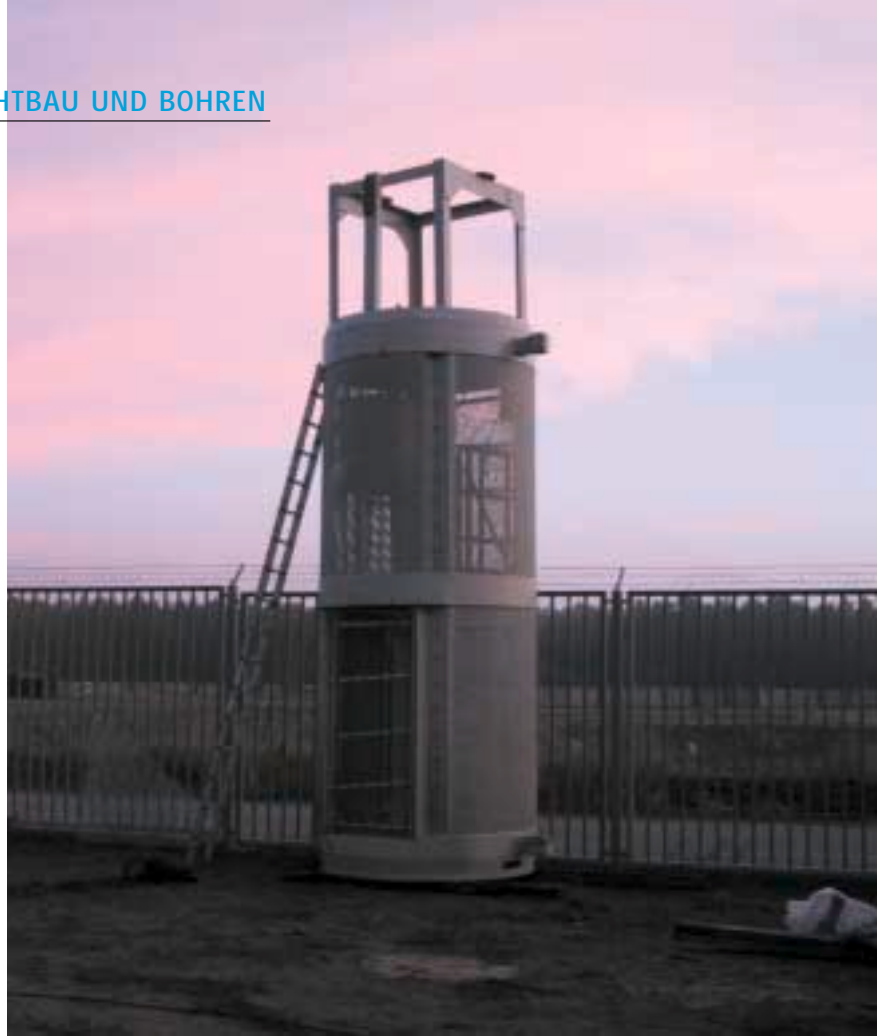
Förderkorb der Kleinen Seilfahranlage nach dem Umbau
