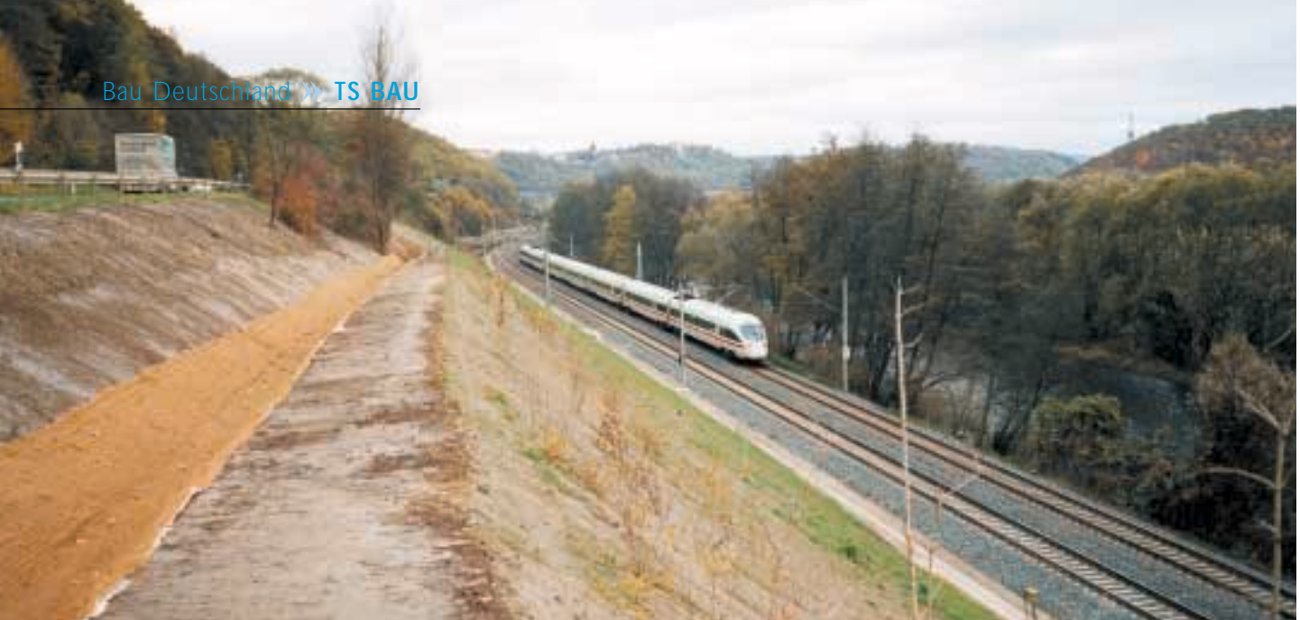
Fertiggestellte Böschung mit Bepflanzung
