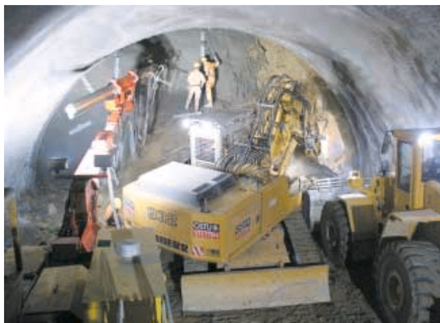
Vortrieb in der Hangschuttstrecke
