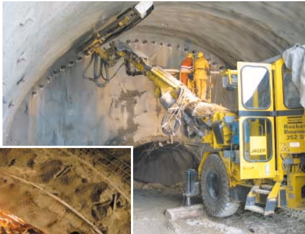
Bild oben: Bohren des Rohrschirms (Hangschuttstrecke)
