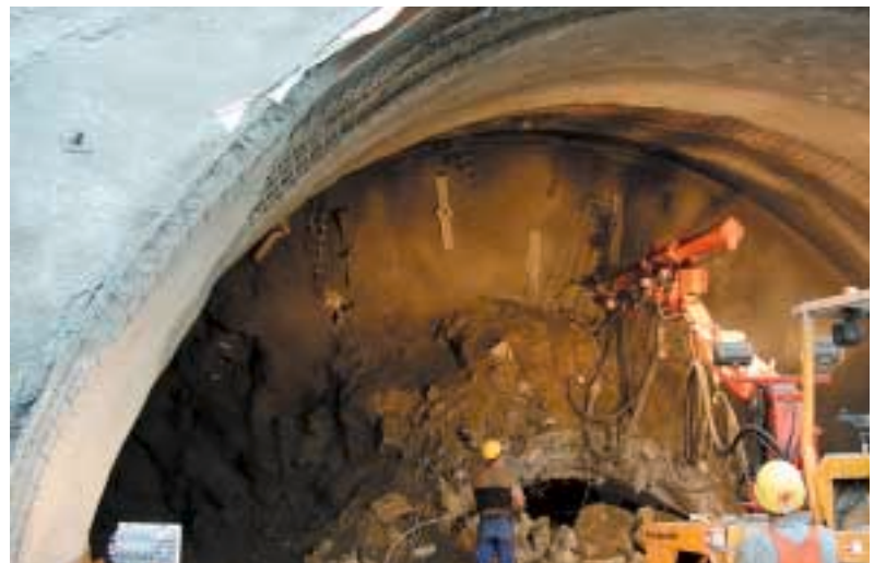
Vortrieb in der Hangschuttstrecke
