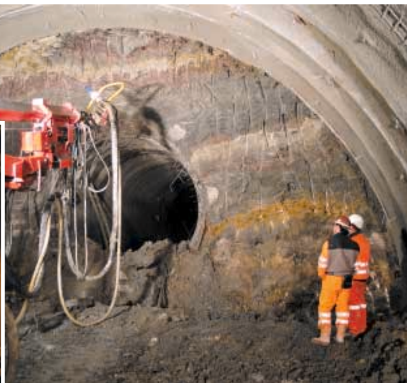
Versiegeln der Ortsbrust in den lehmigen Schichten des ausgelaugten Gipskeupers
