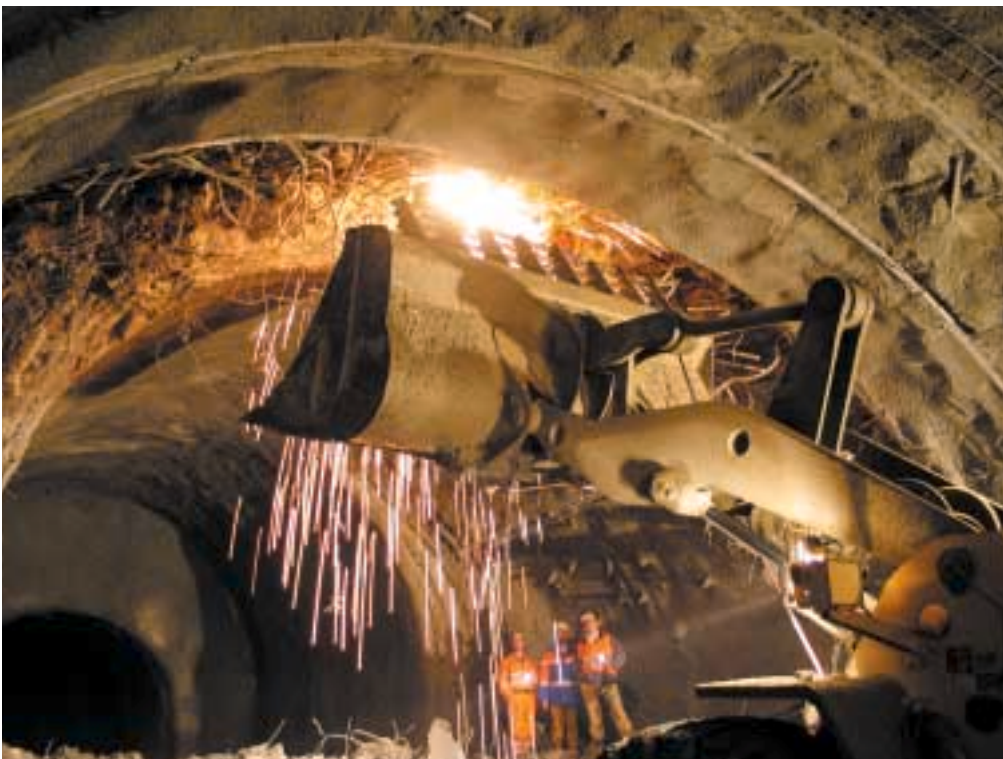
Bild oben: Bohren des Rohrschirms (Hangschuttstrecke)
