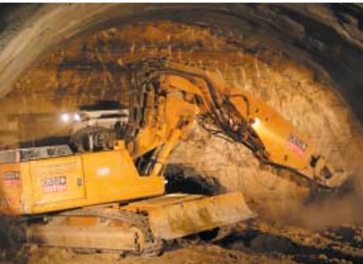
Beräumen der Ortsbrust (mürbe Dolomite des oberen Muschelkalks) mit dem Tunnelbagger
