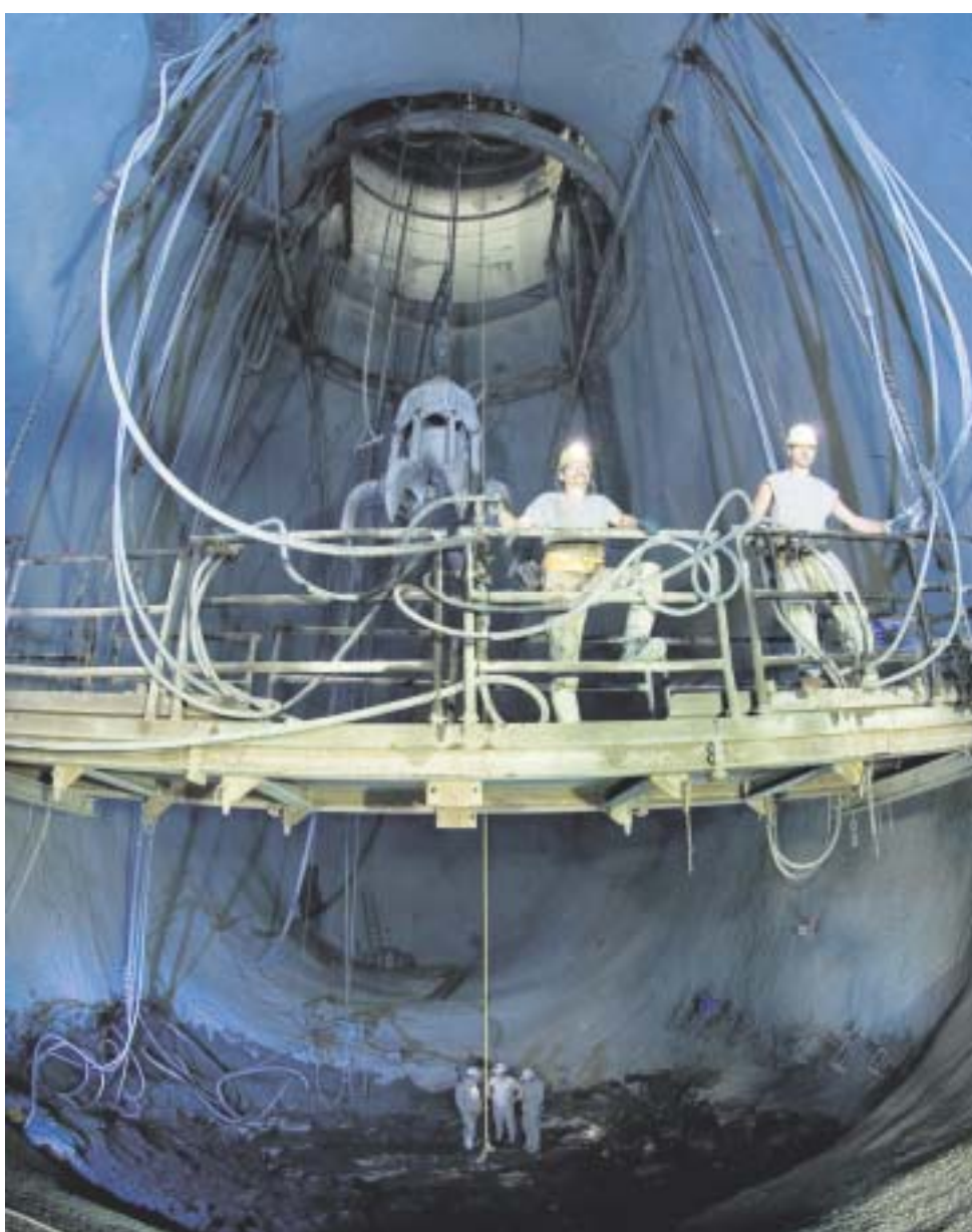
Tieferteufen im Steinkohlenbergwerk Prosper-Haniel in Bottrop.
